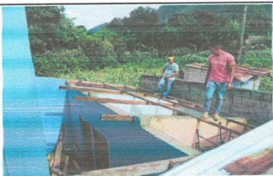
Foto 3: Momento en que se realizan trabajos de reemplazo a la estructura deteriorada.
