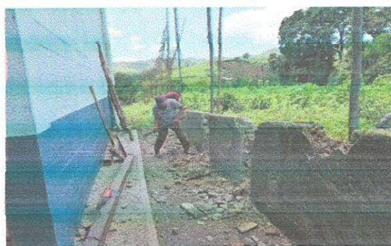
Foto 2: Trabajos realizados durante la realización del remozamiento y sustitución a muro.
