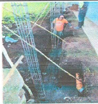
Foto 4: Trabajos realizados para mejoramiento y sustitución a muro.
