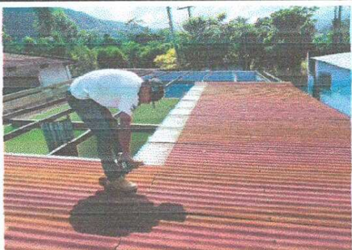
Foto1: Trabajos realizados para y durante la sustitución a techo.
